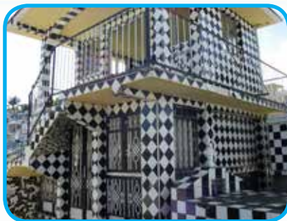
Photo: Mairie de Morne-à-l'Eau
